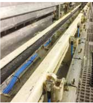
2 Câblage de la mise à la terre fonctionnelle
