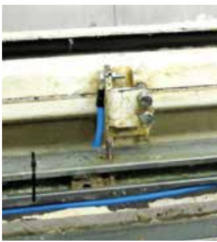
1 Connexion du système de mise à la terre fonctionnelle en cabine de peinture
