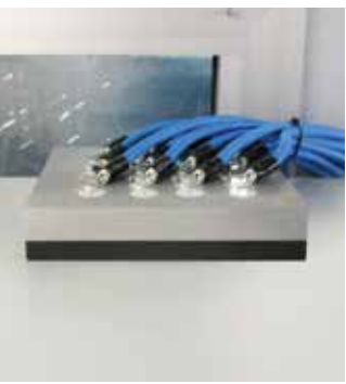
3 Connexion à l'armoire de mise à la terre fonctionnelle
